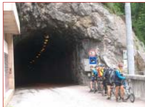
Vor dem „Kühlschrank“-Tunnel
